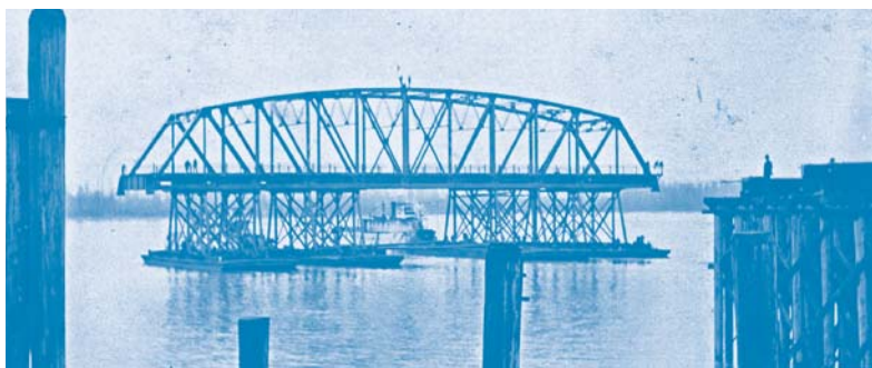
Chiếc cầu nổi được đặt bằng xà lan trong thời gian kiến trúc cầu năm 1917 Cầu Xuyên Bang Lịch Sử Xã Hội, OrHi 101203
